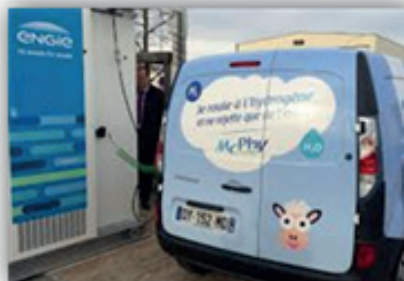
Station de livraison d'hydrogène
