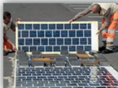
Quand la route devient centrale photovoltaïque
