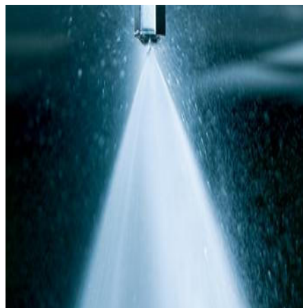
Buse dispositif Drencher
