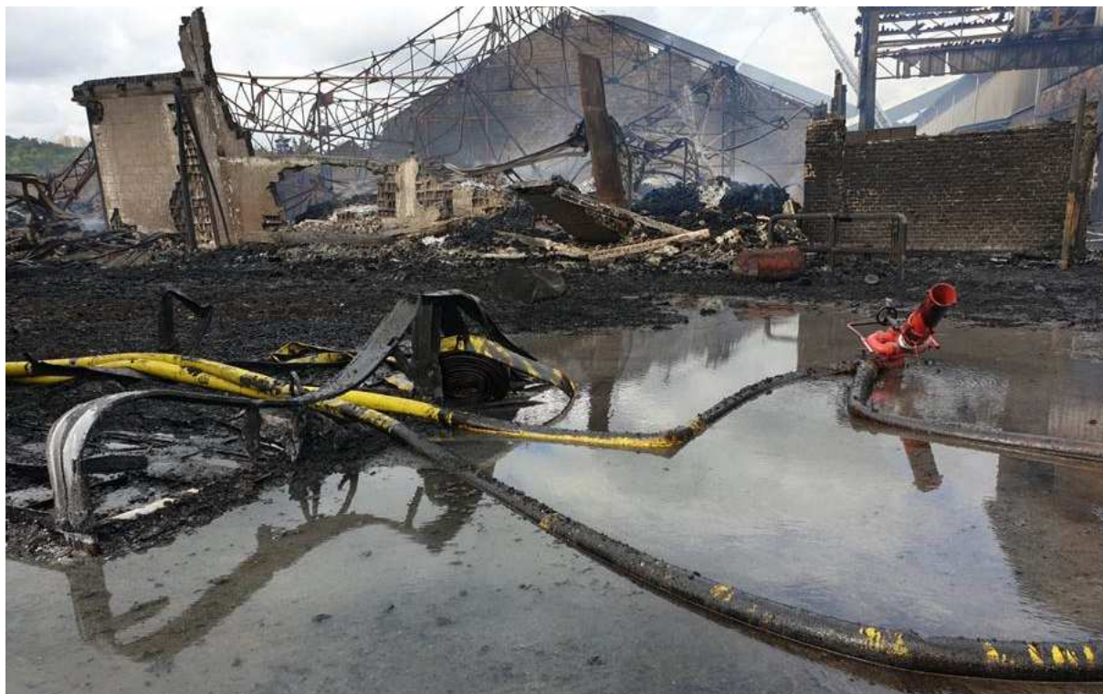
Une démarche permettant au SIS de recouvrir ses capacités opérationnelles doit être initiée dans les meilleurs délais. © SDIS 76
